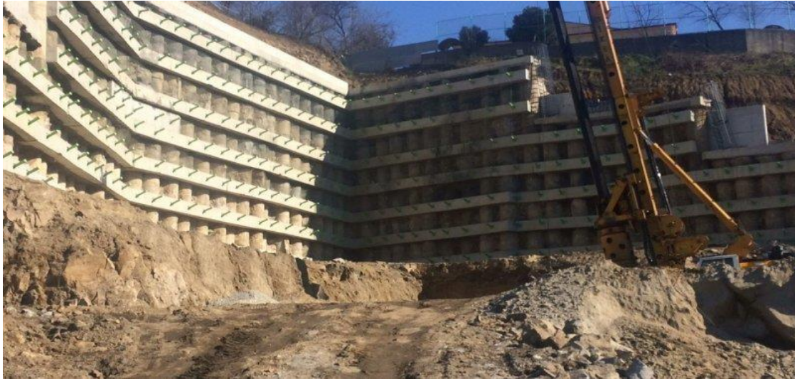
Şekil 7. İksa sisteminden bir görüntü
