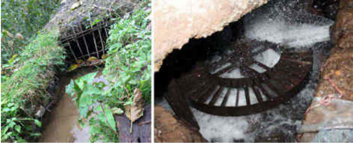
Şekil 8: Su Oluğu, Su Çıkışı ve Çark
