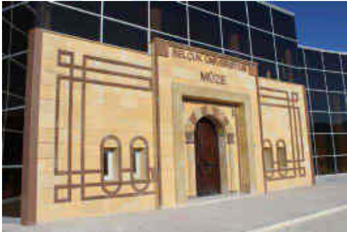
Resim 3: Selçuk Üniversitesi Müze Binası Ön Cephe Görünüm.
