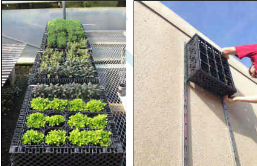
Şekil 6: Yaşayan duvarlarda kullanılan modüller (Kaynak: URL-5)
