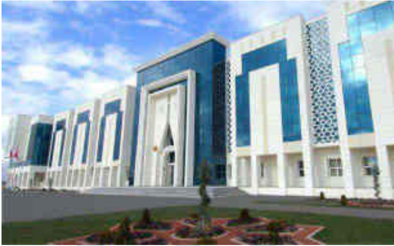
Resim 12: Konya Adliye Sarayı Cephe Giydirme Uygulamaları.
