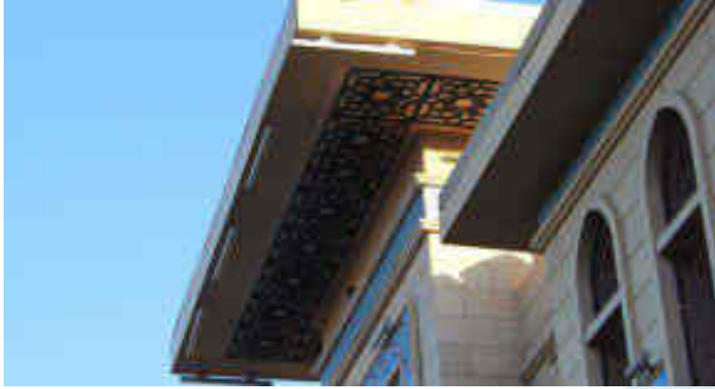
Resim 8: Selçuk Üniversitesi Önü Yaya Üstgeçidi Ön Cephe Detayı.
