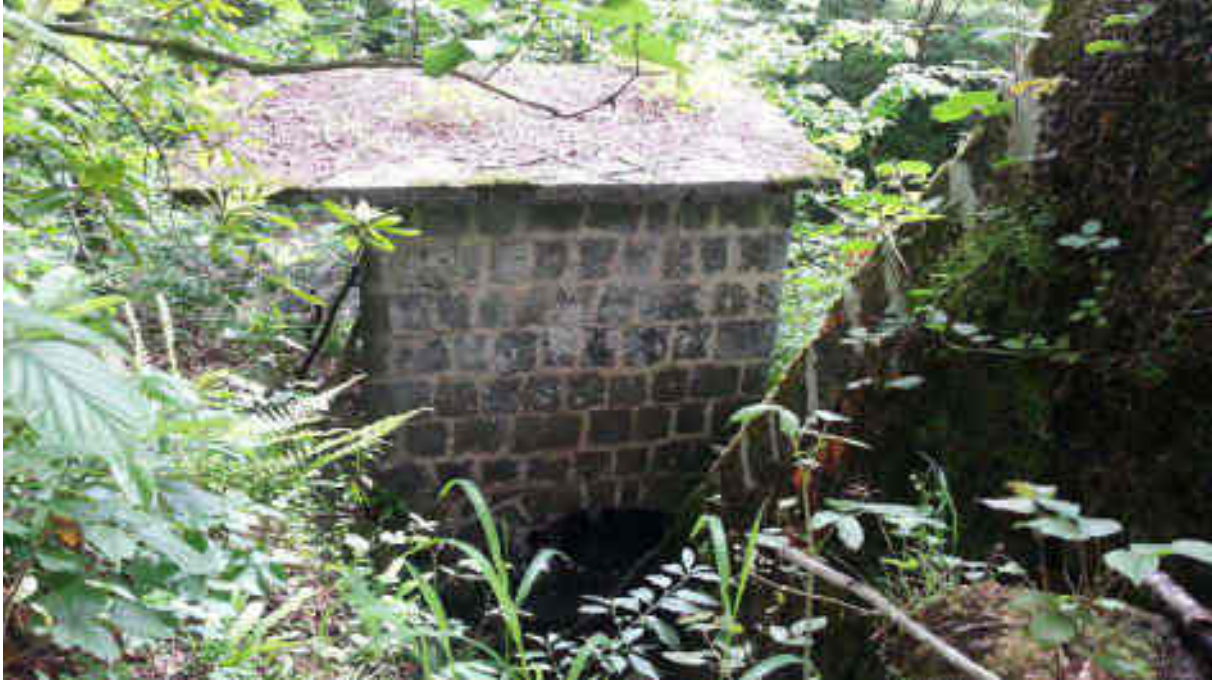
Şekil 6: Sabit Kaya Çıkıntısına Yerleştirilmiş Değirmen Örneği
