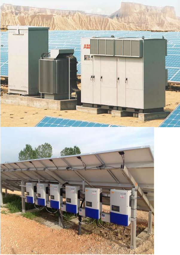
Şekil 9. a) Merkezi inverter sistemi (Voltimum, 2019), b) Dizi tipi inverter sistemi [14]
