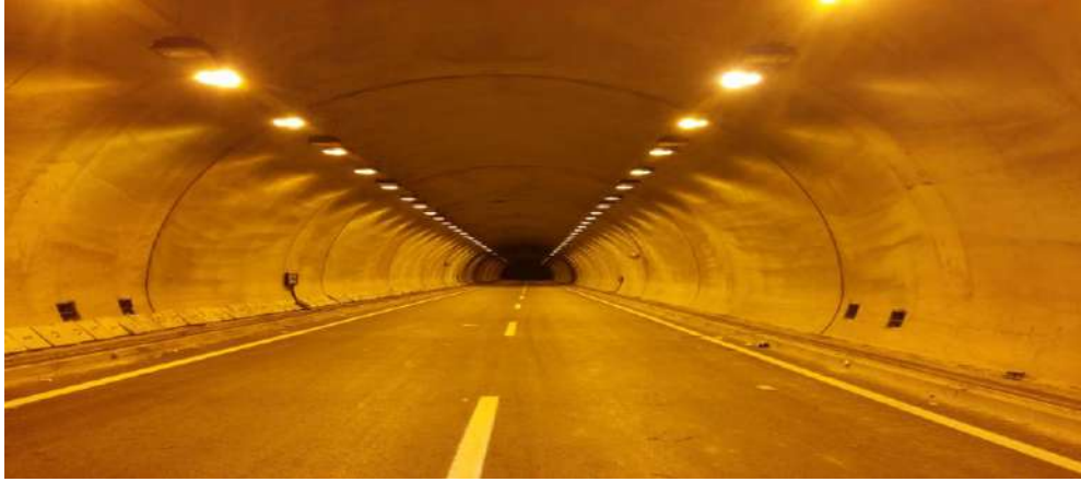
Şekil 2. Sodyum Buharlı Yüksek Basınçlı Armatürle Aydınlatılmış Tünel[2]
