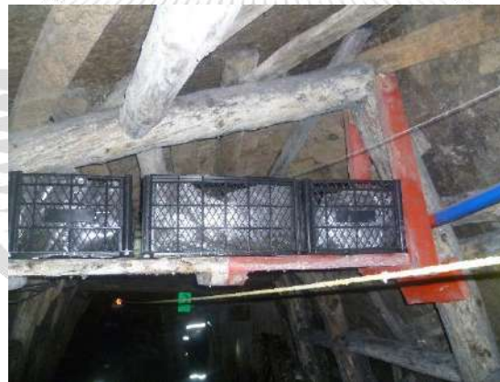
Şekil.4 Su Bekleme barajı
