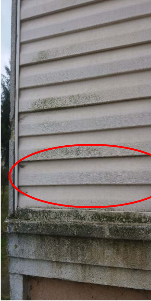
Şekil 7. Kirlenme ve parça kaybı
