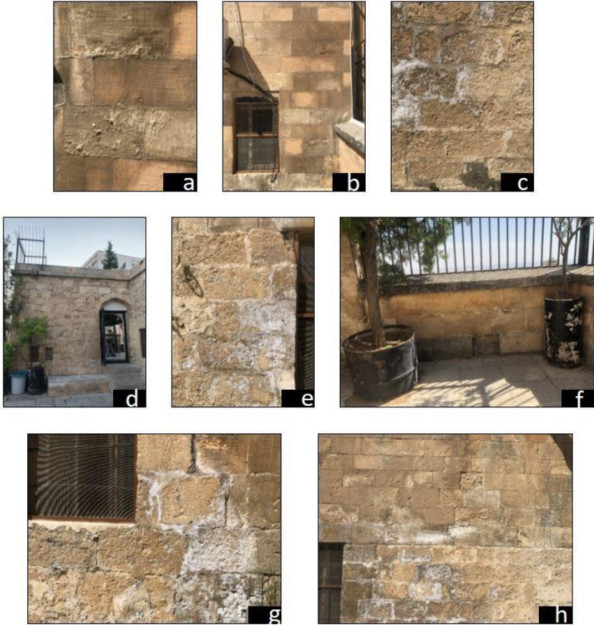
Şekil 5: Şeyh Çabuk Camisinde Meydana Gelen Kimyasal Bozunmalar
