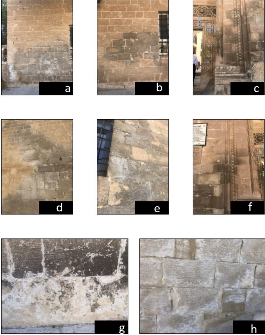
Şekil 5: Latifiye Camii'inde Meydana Gelen Kimyasal Bozunmalar
