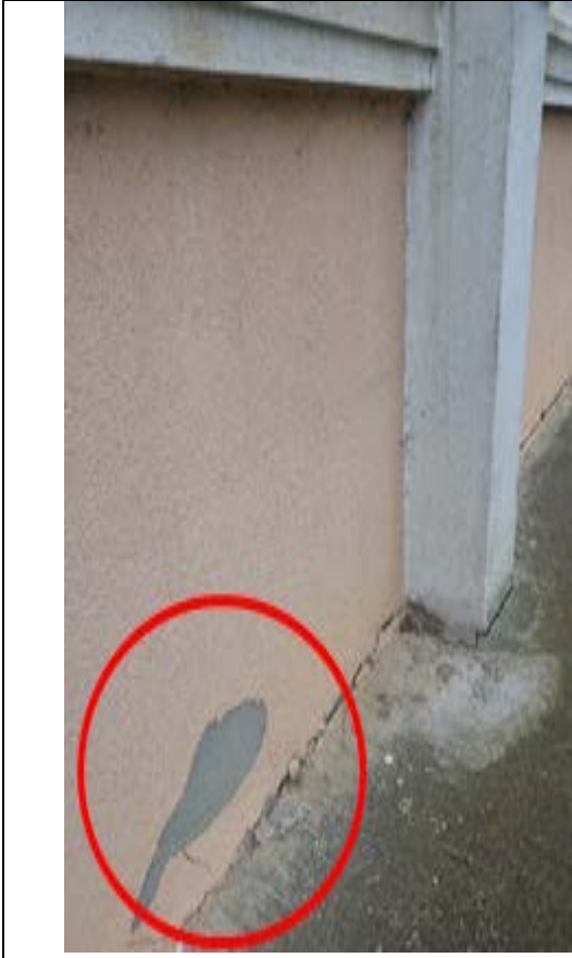
Şekil 9. Boya Dökülmesi
