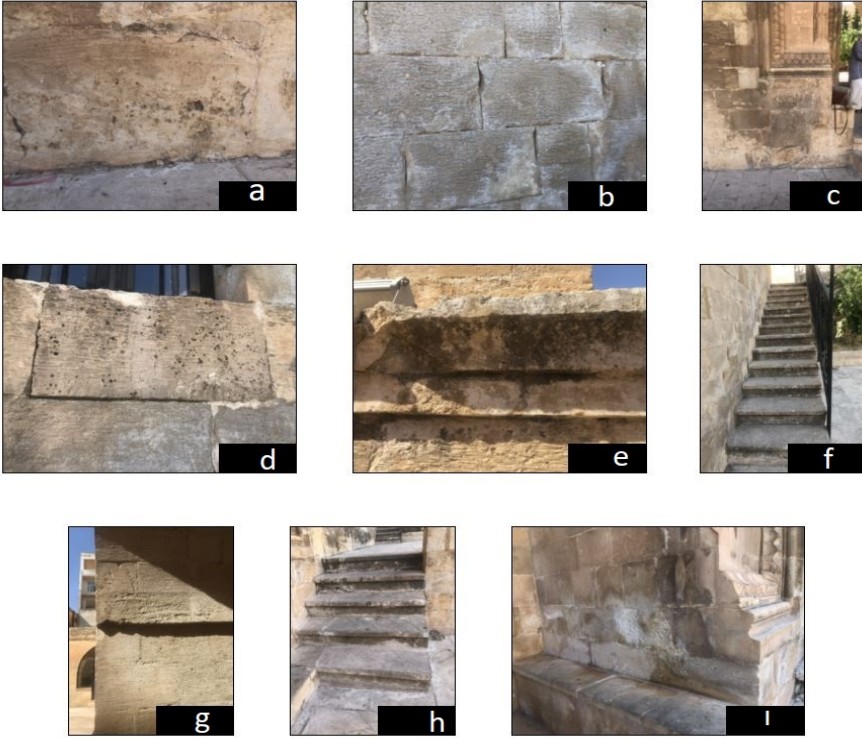
Şekil 4: Latifiye Camii'inde Meydana Gelen Fiziksel Bozunmalar
