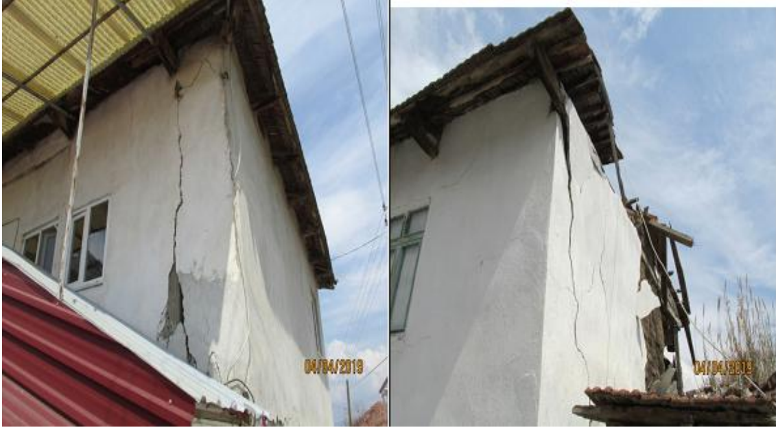
Şekil 3. Taşıyıcı Duvarlarda Görülen Deprem Hasarı Türleri (Acıpayam Uçarı).
