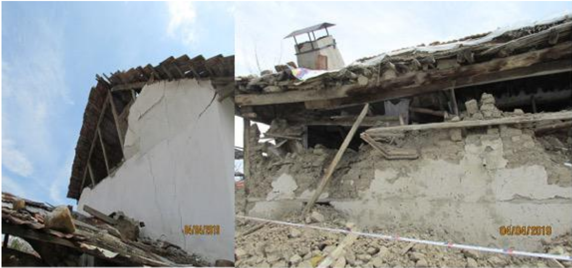
Şekil 3. Taşıyıcı Duvarlarda Görülen Deprem Hasarı Türleri (Acıpayam Uçarı).
