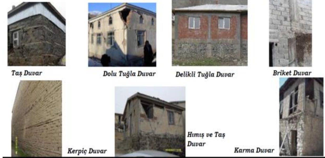
Şekil 1. Kargir Yığma Binalarda Taşıyıcı Duvar Türleri [7].
