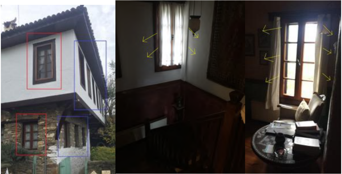
Şekil 13. Pencere boyut, sayı ve büyüklükleri, yapı içi aydınlanma (M. Sağdıçoğlu tarafından çekilmiştir).
