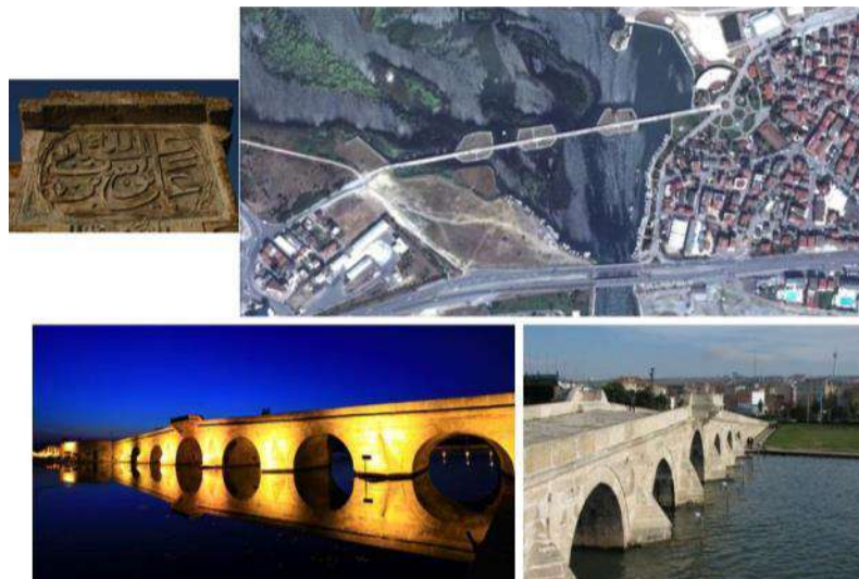
Şekil 20. Sultan Süleyman (Büyükçekmece) Köprüsü (1567) (Url 1).
